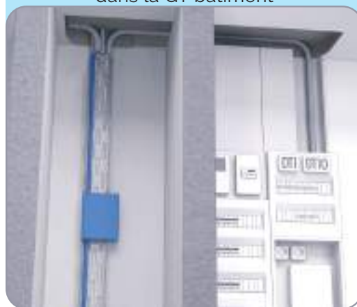
Zoom sur la technique de mise en oeuvre type de l'installation du PBO dans la GT bâtiment
