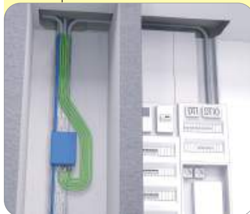
Zoom sur la technique de mise en oeuvre type de l'installation du PBO dans la GT bâtiment
